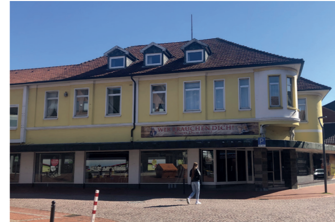
Abb. 57: Für das seit 2017 leer stehende Gebäude Steintorstraße 22 kommen die Planungen für einen Gastronomie- und Hotelbetrieb nicht so recht voran
