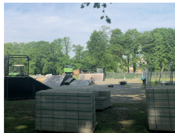
Abb. 29: Baustelle des Jugend- und Freizeitcampus (2023)
