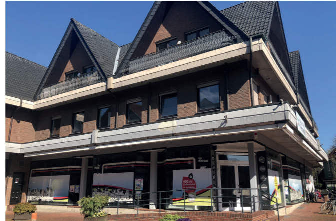
Abb. 56: Die Gewerbefläche des Gebäudes Steintorstraße 11 kann zukünftig in Teilen auch für Wohnzwecke genutzt werden, um den Leerstand zu beseitigen
