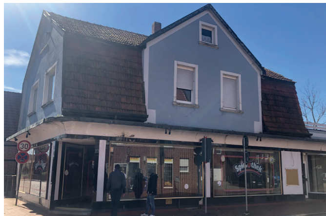
Abb. 55: Derzeit leer stehende und zunehmend verwahrloste Immobilie an der Petersilienstraße (Ecke Hammer Straße)
